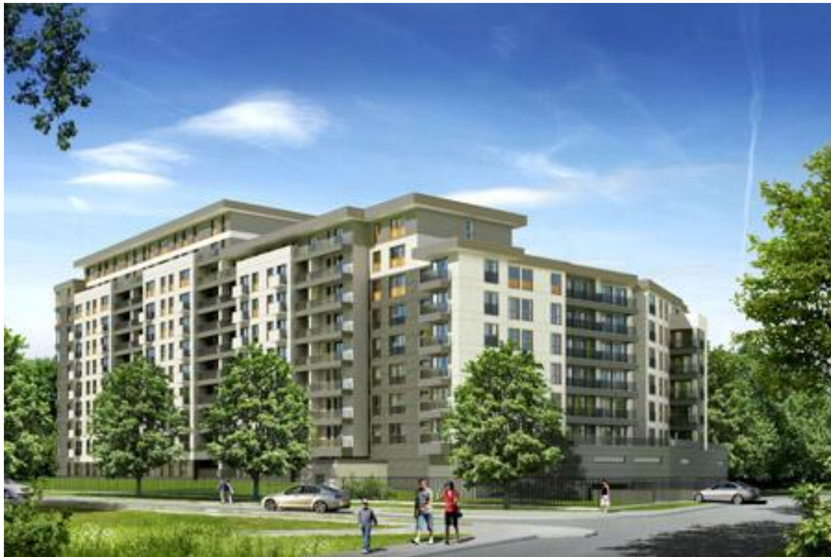
Kompleks ARBORETUM – inwestycja w trakcie realizacji.
