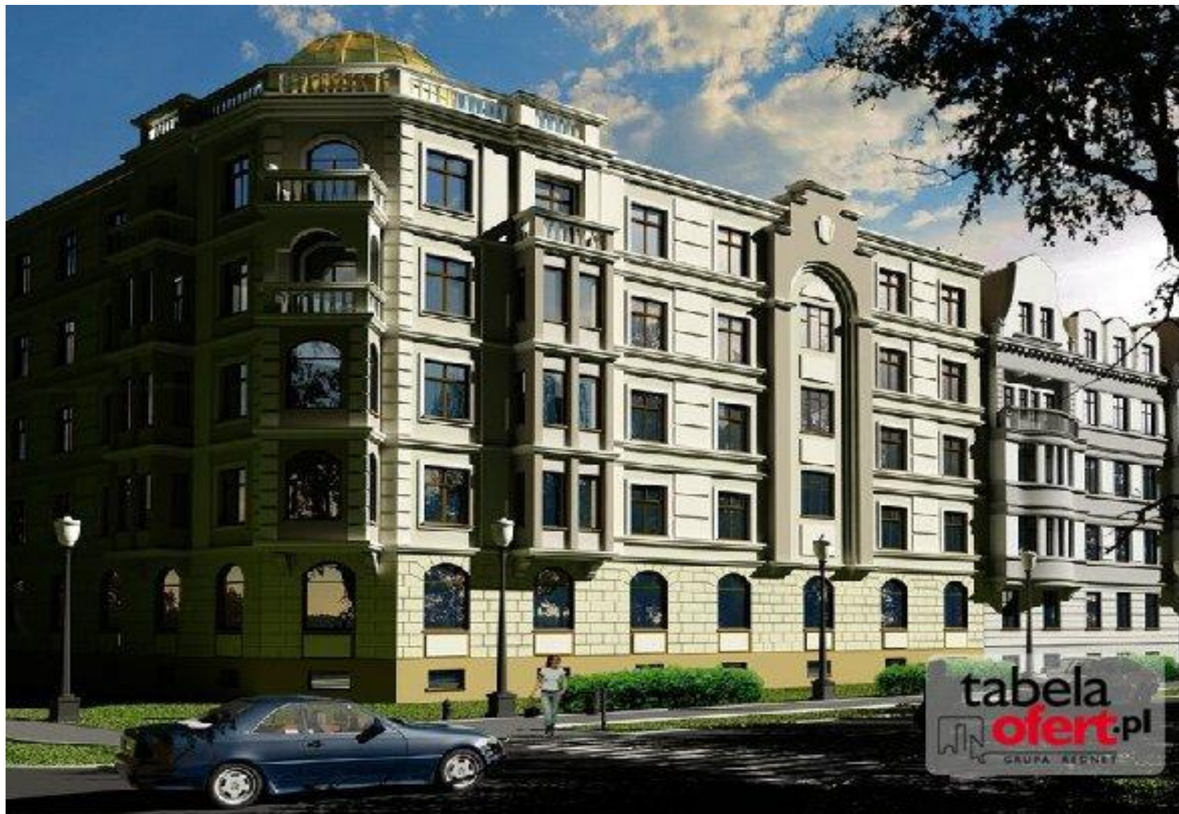
Kompleks HELENÓW PARK – inwestycja w realizacji.
